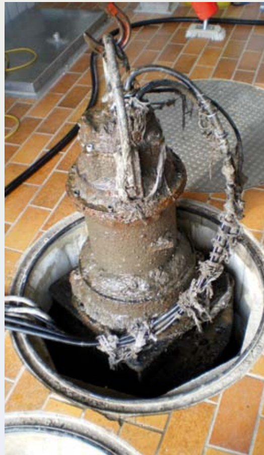
Durch Haushaltsartikel und Fette stark verschmutzte Pumpen.
