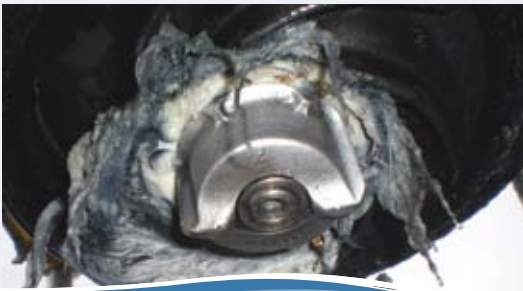
Durch Haushaltsartikel und Fette stark verschmutzte Pumpen.
